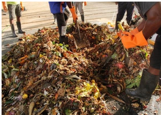
4 රූප සටහන: තෙත් කසළ මිශ්‍ර කිරීමේ සහ වතුර්ථභාගයන්ට වෙන් කිරීමේ ක්‍රියාවලිය (මූලාශ්‍රය: (WACS) වාර්තාව, 2023)
